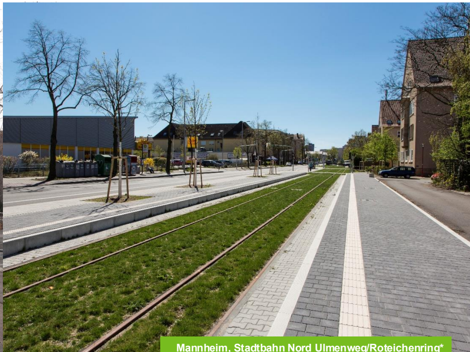
Mannheim, Stadtbahn Nord Ulmenweg/Roteichenring*
