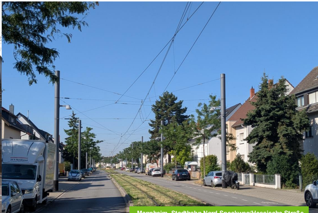
Mannheim, Stadtbahn Nord Speckweg/Hessische Straße
