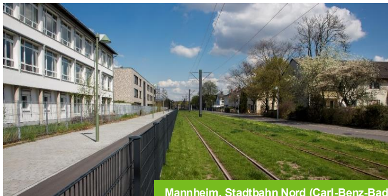
Mannheim, Stadtbahn Nord (Carl-Benz-Bad)
